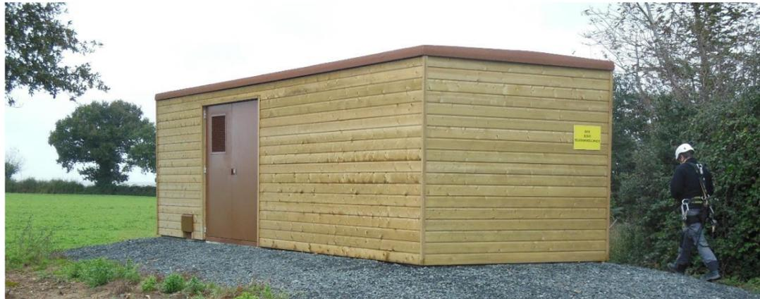
*Figure 10 : Illustration du poste de livraison bardage bois (source : EPURON, 2014)*
